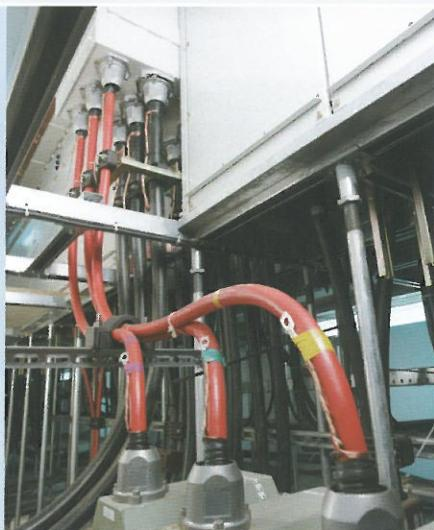
Die Steckendverschlüsse SEIK in gerader Form dienen zum Anschluss von VPE-Kabeln 12-36(52) KV an gekapselte Schaltanlagen und Transformatoren. Sie sind geeignet für Innenkonus-Geräteanschlusssteile nach DIN EN 50180/50181 für den Anschluss-typ 1 (630 A), -typ 2 (800 A) und -typ 3 (1250 A).
